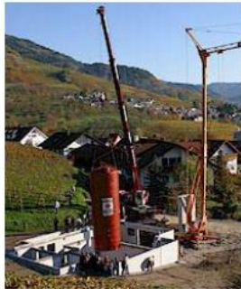
Der 42.800-Liter-Speicher wird in das Solarhaus eingebracht. Zum Heizen wird im Winter die Energie 5000 kWh benötigt. Im Sommer das Wasser des Tanks durch die Sonne von 20°C auf 90°C erhitzt.
